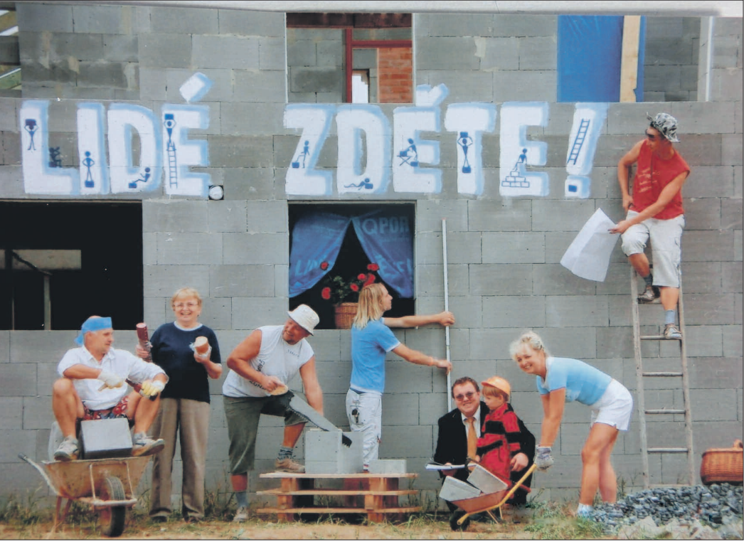
Stavba synova domu
